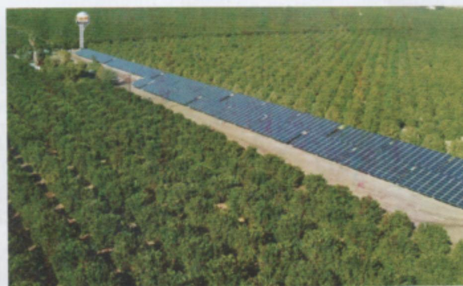
Сл.2. Пример примене соларних заливних система за вођњаке до 400 хектара са акумулационим водоторњем
